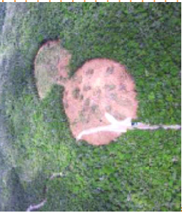
現在強行工事されているヘリパッド(N1)
